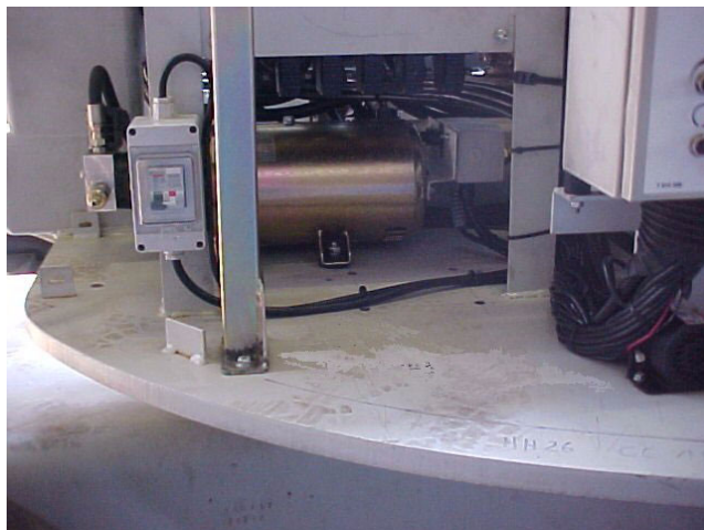
Kuva 8 - Kuormausgeneraattori ja sen suojakonepelti
